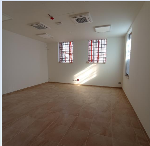
PIANO PRIMO – LAVORI IN CORSO
