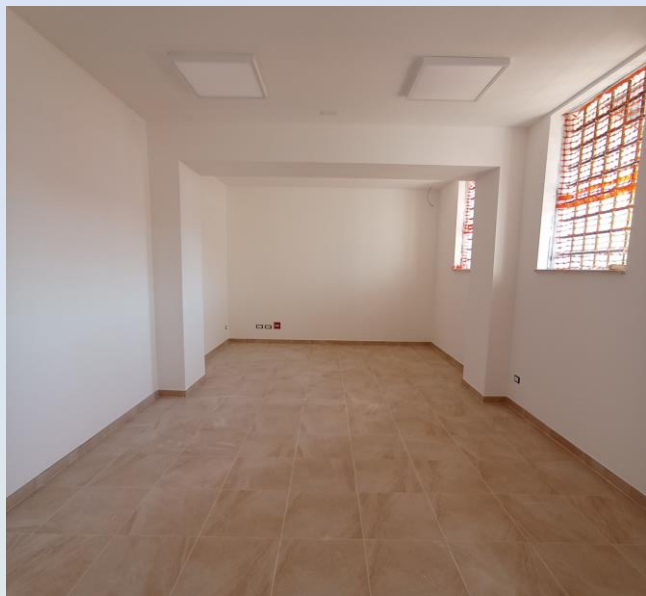
PIANO PRIMO LAVORI IN CORSO
