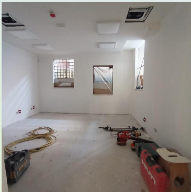
PIANO TERRA – LAVORI IN CORSO
