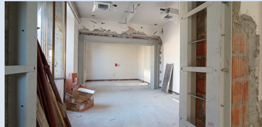
PIANO PRIMO – BIBLIOTECA - FASE DI ESECUZIONE LAVORI
