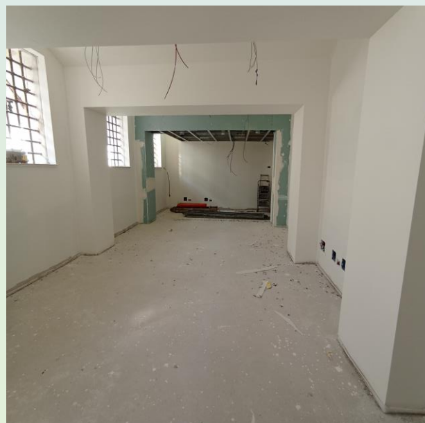
PIANO TERRA – LAVORI IN CORSO
