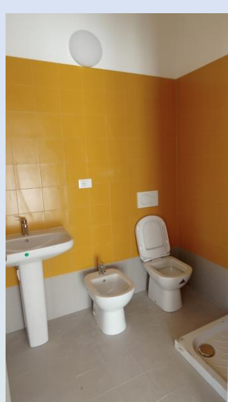
BAGNO CAMERA DETENTIVA
